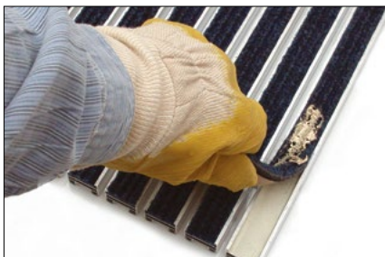
Fjern den beskadigede ribbelægningsstrimmel ved hjælp af en skruetrækker.
